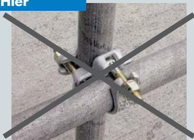
Blocage par collier à boulons serrés à la clé
