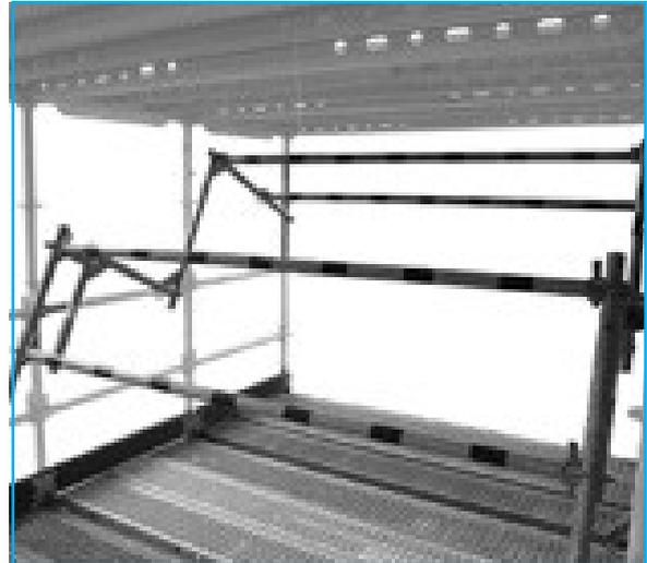
En basculant pour permettre l'approvisionnement de la recette, l'opérateur se retrouve protégé par un nouveau garde-corps l'isolant de la zone à risque.
